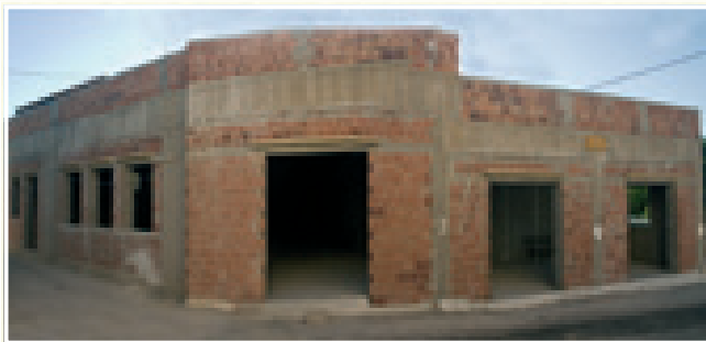
Τό ὑπό ἀνέγερση Ἑνοριακό Κέντρο
