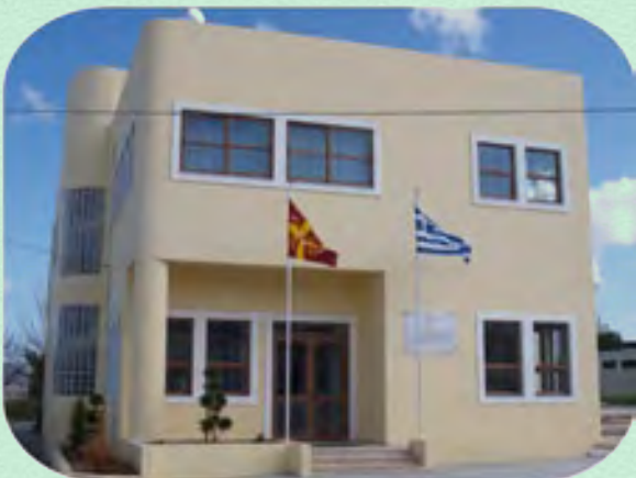
Ἐξωτερικὴ ὄψις τοῦ Φαλδάμειου Οἴκηματος
